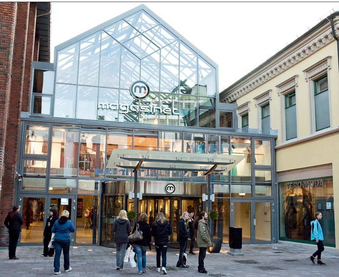
Kjøpesenteret Magasinet på Bragernes er rehabilitert og har fått ny hovedinngang mot Storgata.
